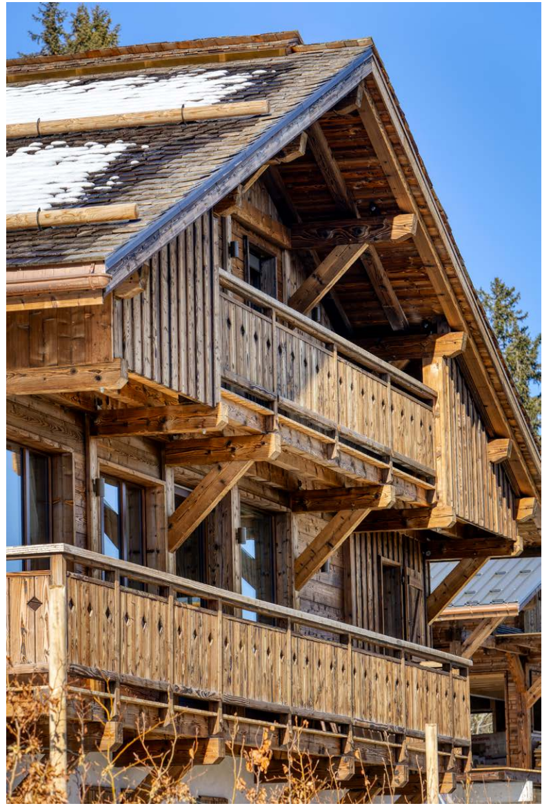
La structure poteau-poutre apporte ce caractère architectural authentique et complexe, emblématique de l'esprit alpin.
